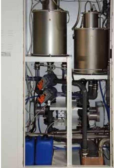
Blick in den installierten eChiller, der 45 kW Leistung bringt und mit R718 (Wasser) als Kältemittel arbeitet – das befreit Betreiber nachhaltig von zeit- und kostenaufwendigen Wartungspflichten.
