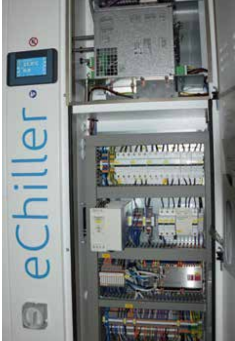
Blick in den installierten eChiller, der 45 kW Leistung bringt und mit R718 (Wasser) als Kältemittel arbeitet – das befreit Betreiber nachhaltig von zeit- und kostenaufwendigen Wartungspflichten.
